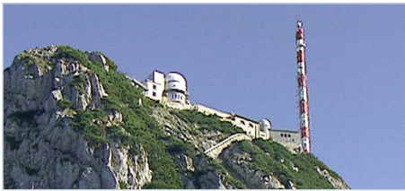
DVB-T-Sendemast auf dem Wendelstein
